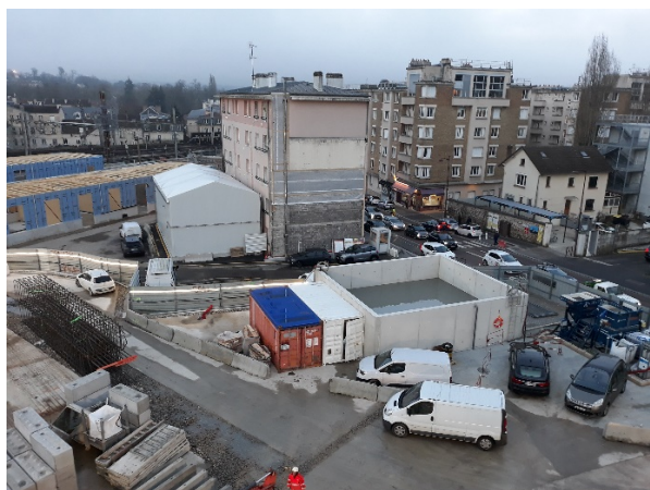
Le chantier rue de la gare la Porte de Buc
